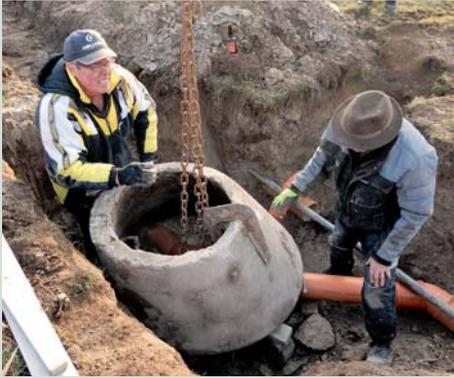
Rudi Schien (links) und Martin Baur setzen einen Kontrollschacht.
